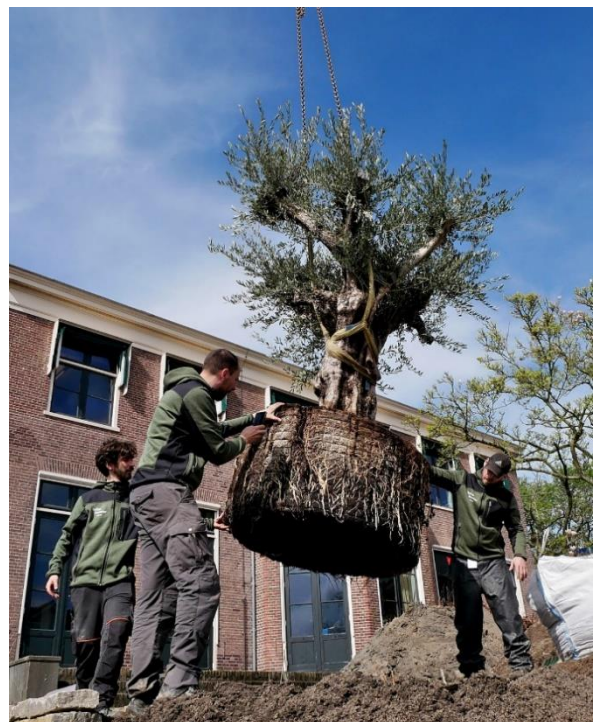
Met een kraan wordt een olijf geplaatst
